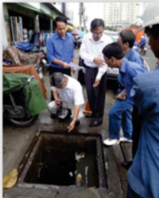
有毒ガスの確認作業 Toxic gas Check (July 2013)
