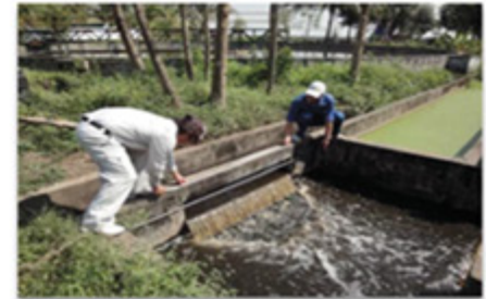
ヤンゴン市下水処理場における現場調査 Pre-FS in Yangon city wastewater treatment
