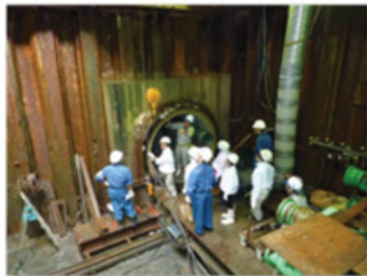
現場見学(推進工事)の様子 Site observation (Jacking methods)
