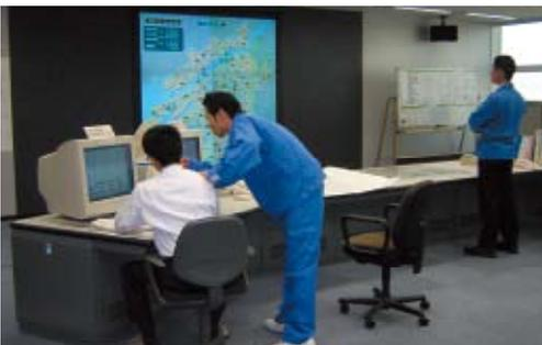
市内全域の配水管に設置した配水テレメータ(流量計・水圧計)を用いて、配水状況を監視するもので、平常時における断水・通水等の検討や、災害・事故等緊急時における急応配水計画の立案などに活用している。
